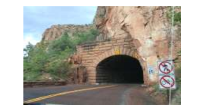
Camel Tunnel 입구 각종 사진
